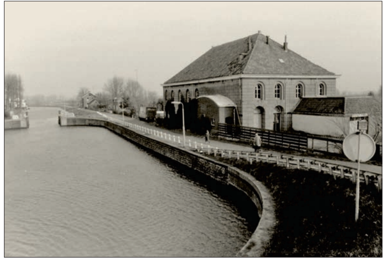
Het in 1993 gesloopte gemaal Arkelse Dam bij Arkel.
